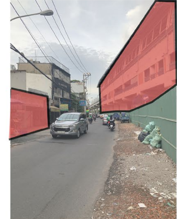
CÔNG TRƯỜNG- BỎ HOANG
